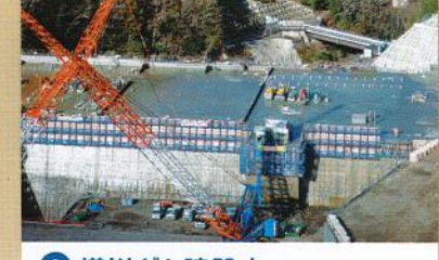
8 桜川ダム建設中 完成すれば高さ、容量とも県内最大のダムとなります。現在工事中ですが見学可能で、ダムカード風記念写真撮影スポットが用意されています。
